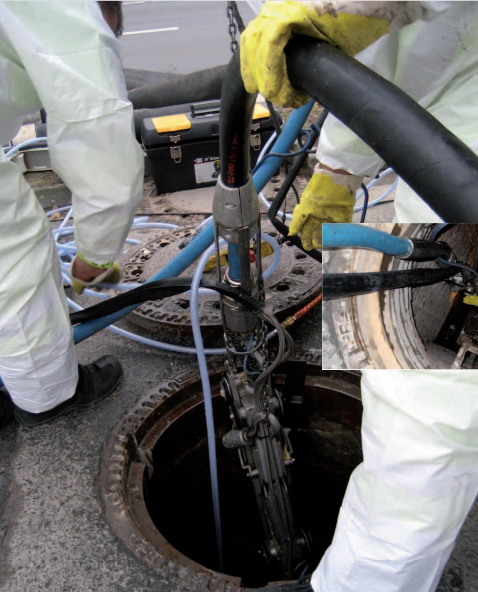
Lors de la réhabilitation de conduites d'eaux usées non accessibles, des systèmes robotisés peuvent également être utilisés en plus de la réparation avec les systèmes de revêtement partiel. A l'aide de la technologie robotisée, les endroits endommagés peuvent être comblés soit avec des systèmes minéraux soit avec des systèmes de réaction d'ombran.
