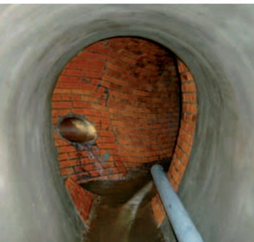
La réussite de toute réparation dépend principalement du respect et de l'exécution minutieuse des différentes étapes de réparation. Si les sous-sols présentent de fortes irrégularités, des éclatements ou un revêtement béton déficient, il faut exécuter un reprofilage. Ce n'est qu'ainsi que vous obtiendrez un sous-sol au revêtement correct. Le revêtement ultérieur avec ombran protège l'ouvrage des contraintes dues à l'atmosphère de la canalisation.
