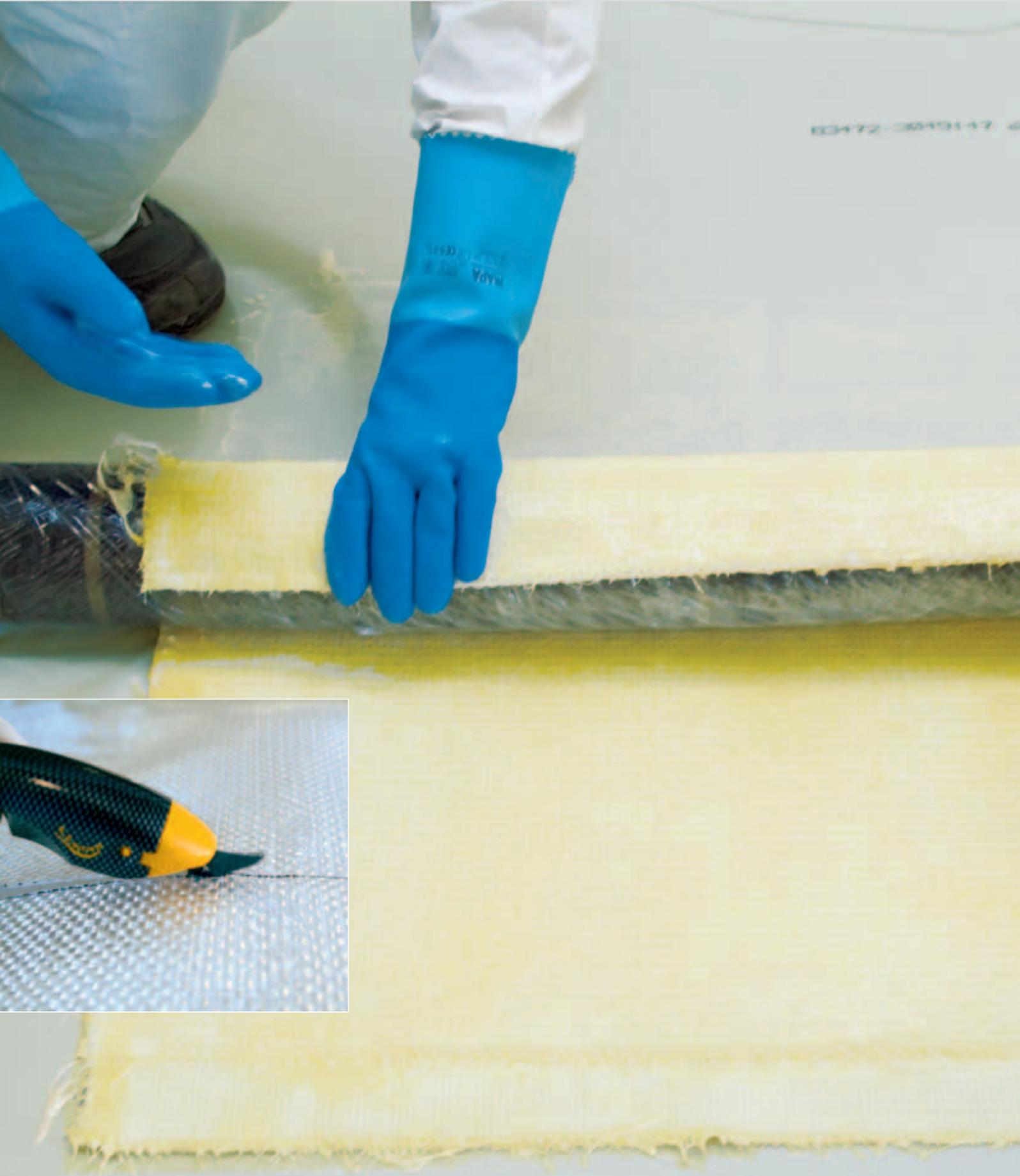
Le tableau des dommages ne requiert pas toujours une réhabilitation complète de la conduite. Les dommages limités à une zone peuvent être réparés de manière ciblée avec le procédé de revêtement partiel. L'étanchéité et le renforcement statique de l'endroit endommagé sont alors en premier plan. En cas de forte infiltration et d'endommagement de la conduite, un revêtement partiel peut également être nécessaire comme mesure préliminaire pour la rénovation globale avec le procédé de chemisage.
