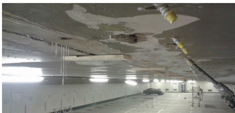
Injection des joints de plafonds
