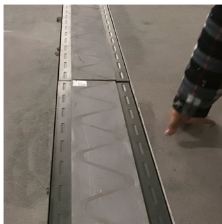
Application du profil MC-Floor Connect CP
