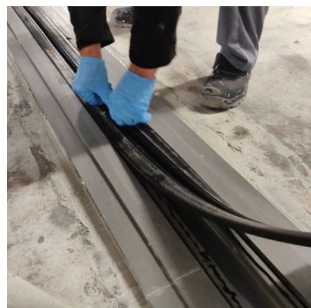
Collage du caoutchouc d'expansion dans le profil de joint MC-Floor Connect CPS
