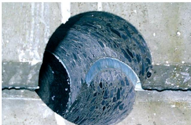
Joint d'étanchéité avec MC-Injekt GL-95 TX
