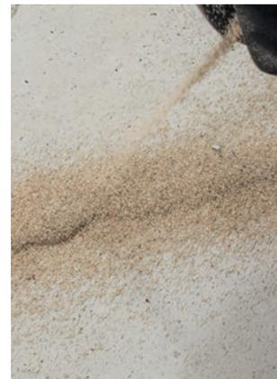
5. Saupoudrez la fissure remplie de résine avec du sable de quartz. Si nécessaire, répétez les étapes 4 et 5 pour les fissures larges et profondes.
