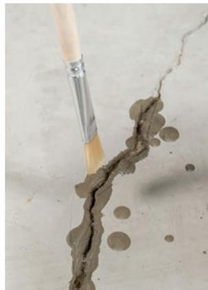
6. Application au pinceau, à la spatule, etc. Remplissez complètement la fissure avec de la résine.
