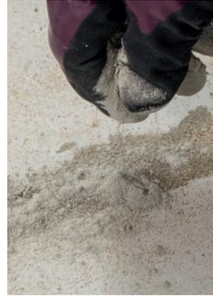
**8.** Pour l'ajustement optique (facultatif), saupoudrez avec de l'enduit Nafuquick / Emcefix.
