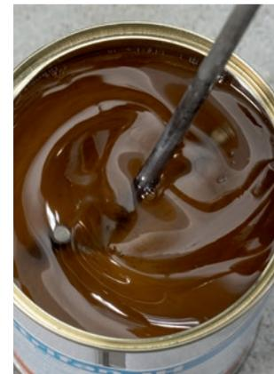
3. Mélangez soigneusement les composants jusqu'à l'obtention d'un mélange homogène.
