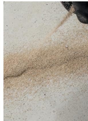
7. Saupoudrez la fissure remplie de résine avec du sable de quartz. Si nécessaire, répétez les étapes 6 et 7 pour les fissures larges et profondes.
