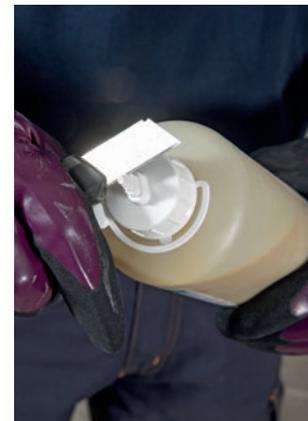
5. Coupez l'extrémité de la bouteille en fonction de la largeur de la fissure.
