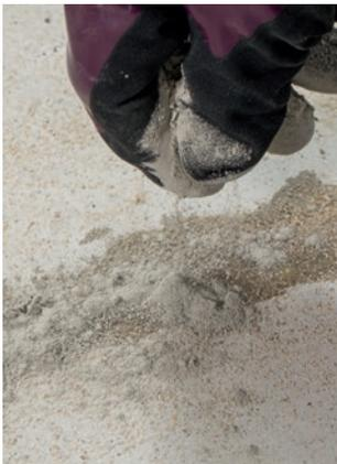
**8.** Pour l'ajustement optique (facultatif), saupoudrez avec de l'enduit Nafuquick / Emcefix.
